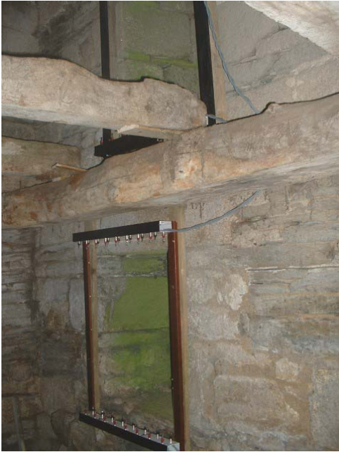
Fig 4 : installation des modules infrarouges devant une fenêtre de sortie.
