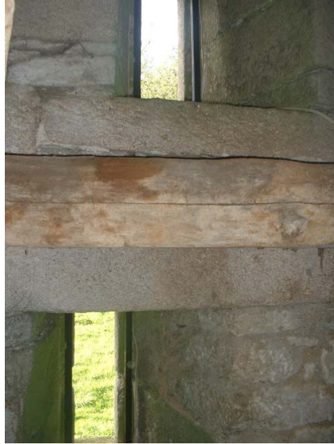
Fig 5 : installation des modules autour d'une meurtrière de sortie. Les rangées de faisceaux sont ici réduites à 2 diodes chacune.
